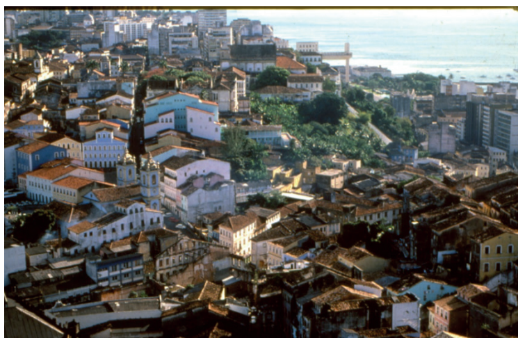
Figura 7: Vista aérea panorâmica do Centro de Salvador
